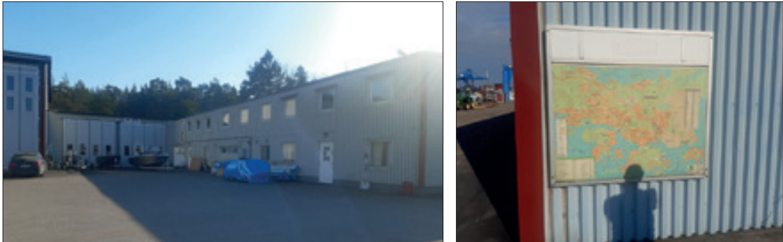
Figur 7. Övernattningsutrymmena är idag inrymda innanför de fem bortersta fönstrena på övervåningen. Detta område går under benämningen det södra ändringsområdet.
