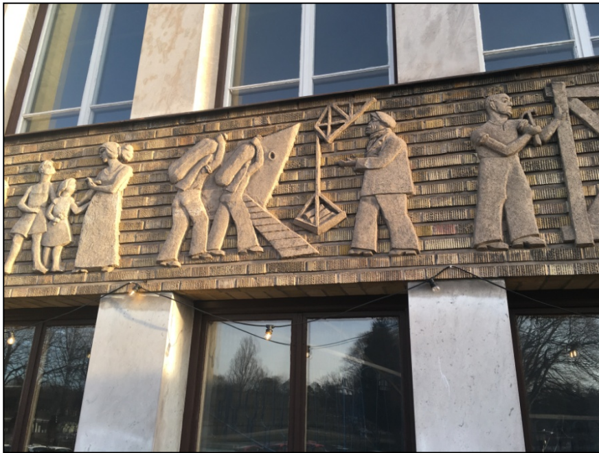
Detalj av fasaden mot Järntorget Foton: Åke Andersson
