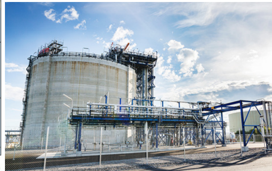
Exempel på atmosfärisk LNG-cistern i Pori (Skargas).
