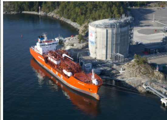
Exempel på atmosfärisk LNG-cistern i Nynäshamn (Linde).
