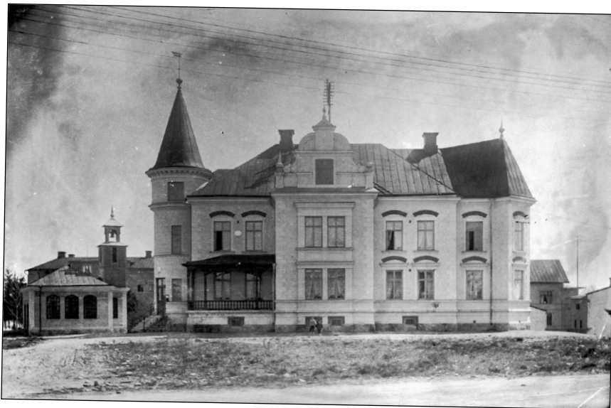
Telegrafhusets västsida i sin ursprungliga utformning, med brandstationen till vänster.
