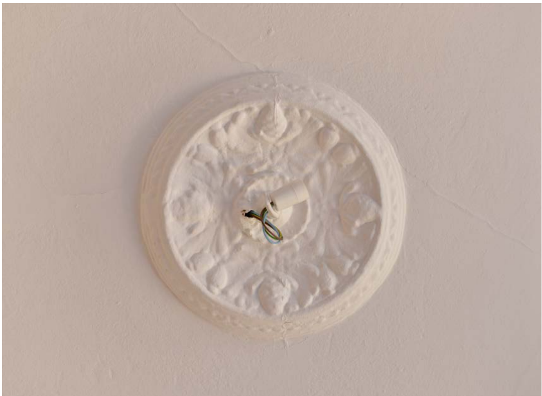
Bild 20. Detalj av takrosett med kottar. (SLM D2021-0239)
