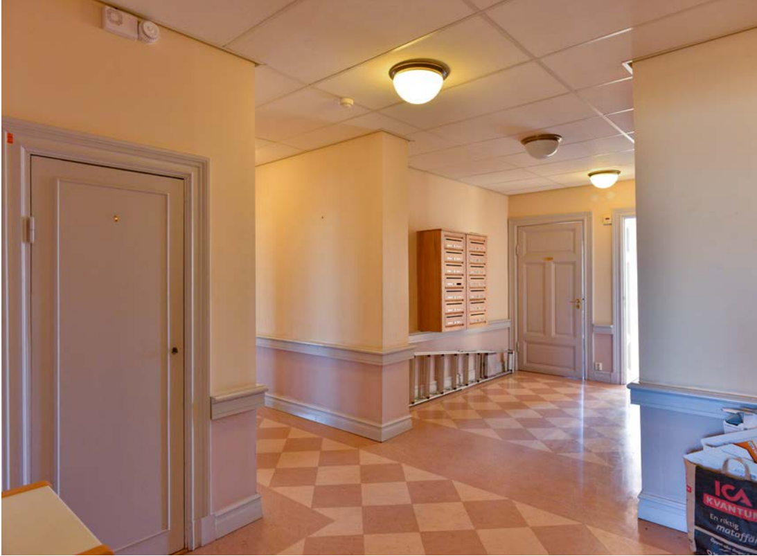
Bild 5. Korridoren på bottenvåningen. Det nedpendlade taket döljer ventilationstrummor. Ytskikten på golv, väggar och tak är från senare tid. (SLM D2021-0224)
