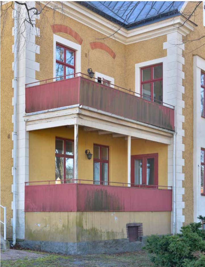
Balkongen på den västra fasaden fick sitt nuvarande utseende vid ombyggnaden 1948. Stommen är av stål och fronterna är av småkorrugerad plåt. Tidigare fanns här endast en terrass med ett tak över. (SLM D2021-0217)
