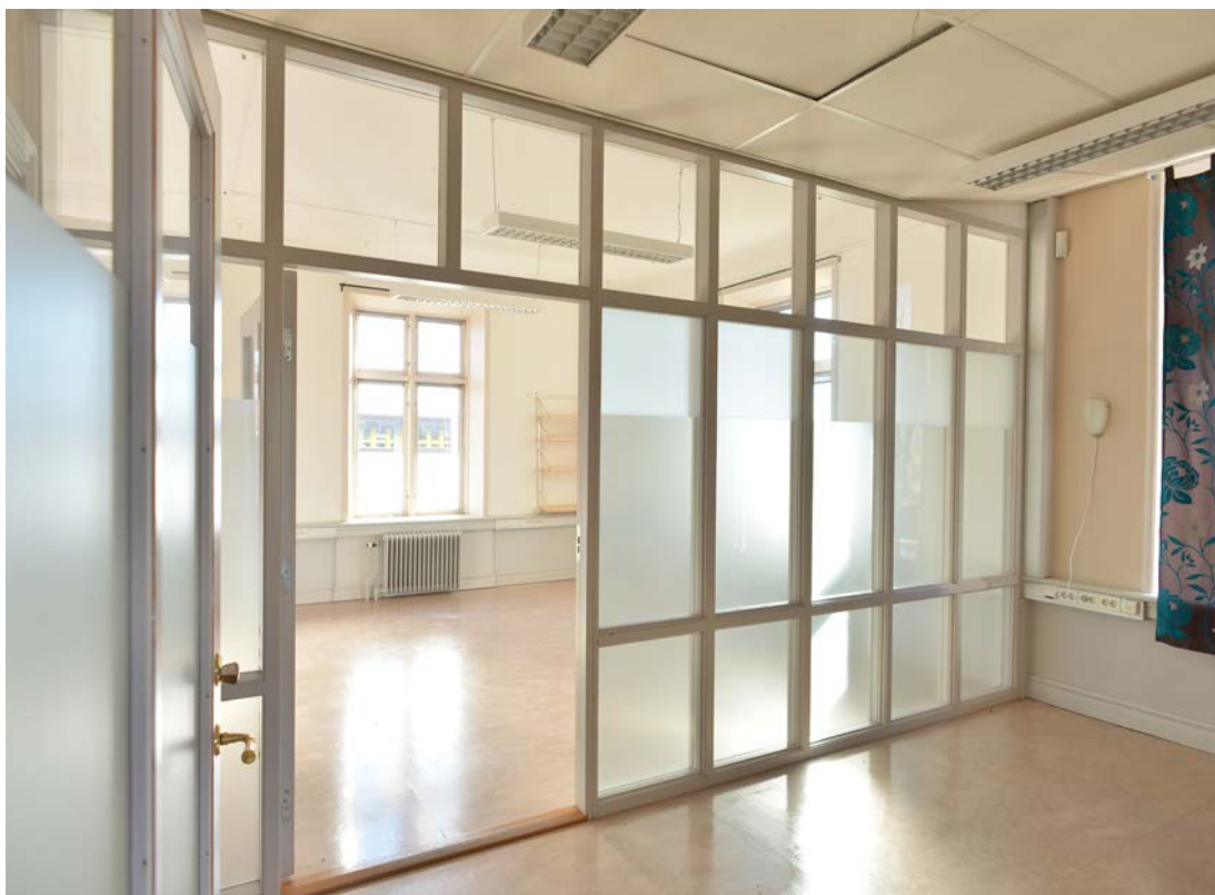
Bild 9. En glasad vägg som uppfördes vid ombyggnaden 1988. (SLM D2021-0228)
