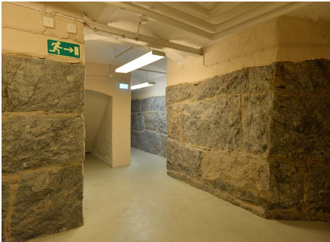
Bild 21. Källarens korridor där de stora grundstenarna är synliga. (SLM D2021-0240)
