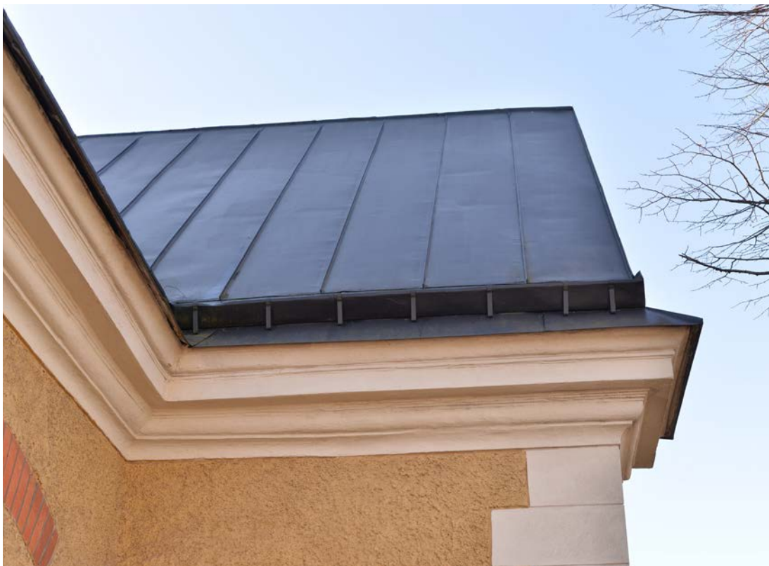
Detalj av taklist och taktäckning. Idag ligger falsad plåt i bandtäckning och fotränna med konsolkrokar, i utförande från 1980-talet. Tidigare var plåten skivtäckt med parallella tvärfalsar. (SLM D2021-0219)
