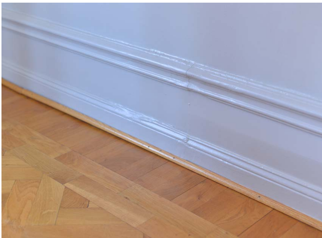
Bild 18. Detalj av golvlisen i samma rum som föregående bild. Sockeln är den högre varianten, vilken sannolikt är ursprunglig. (SLM D2021-0237)
