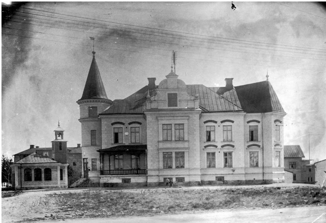
Gnistan 1 fotograferad från norväst före 1904 med sin ursprungliga exteriöra utformning. Skillnader mot idag märks framförallt i tornes höga spira, gavelpartiet och verandans utformning samt fasadernas listverk. I bakgrunden till vänster syns Oxelösunds första brandstation. (SLM M022389)
