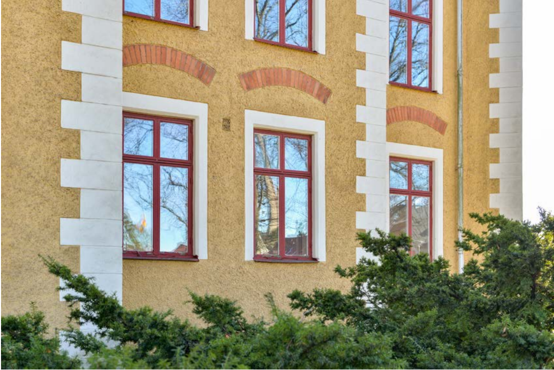
Fönstren på den västra sidan byttes sannolikt ut vid ombyggnaden 1948. Dimensionerna är smäckra och bågarna har valsat glas. Notera de många språng som skapas tack vare byggnadens oregelbundna planform. (SLM D2021-0216)
