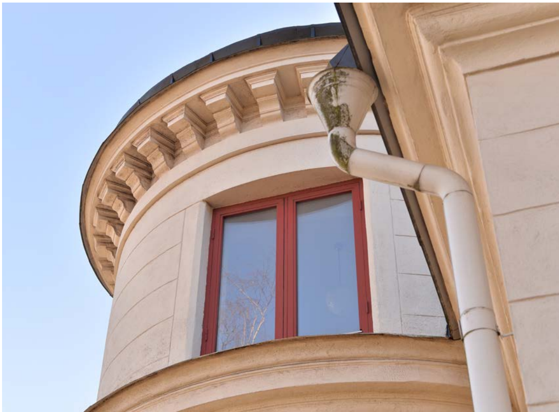
Detalj av trappornets listverk med tandsnitt. Fönstren på trappornet var ursprungligen småspröjsade, men fick sitt nuvarande utseende vid ombyggnaden 1948. (SLM D2021-0218)
