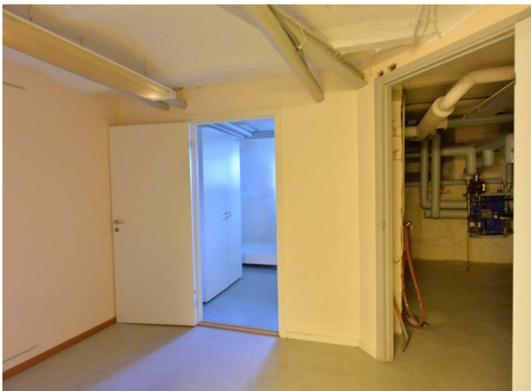
Bild 22. Bild av omklädningsrum och teknikrum i källaren. (SLM D2021-0241)
