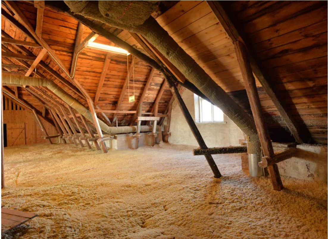
Bild 23. Vindsutrymmet i den östra delen är oinredd och isolerad med lösull av cellulosa. (SLM D2021-0242)
