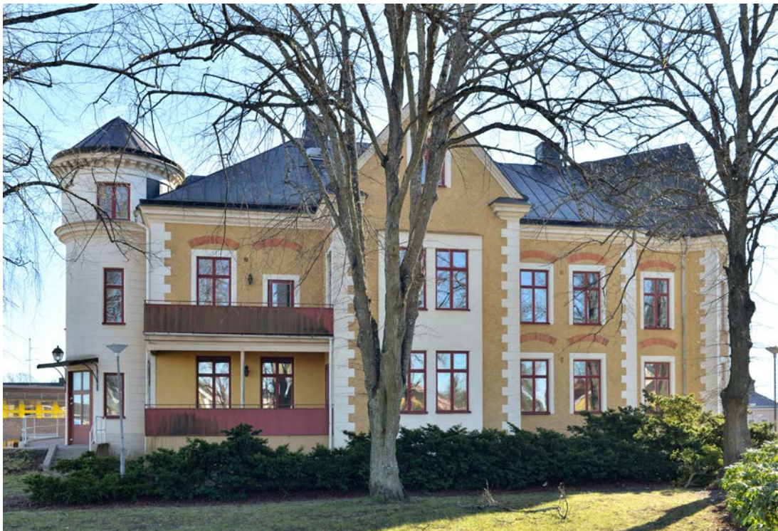
Byggnadens västra sida med trappornet till vänster i bild. Fastighetsgränsen går i linje med de närliggande buskarna. (SLM D2021-0212)
