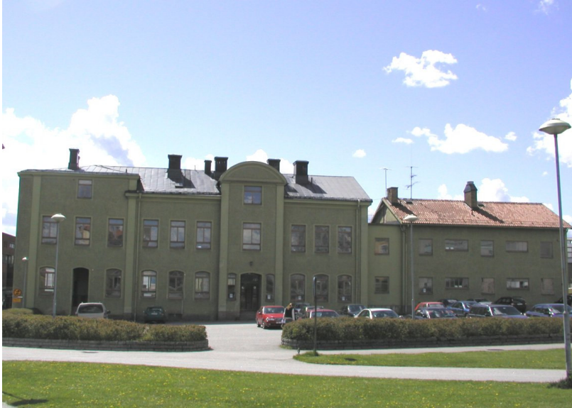
C-skolan sedd från norr
