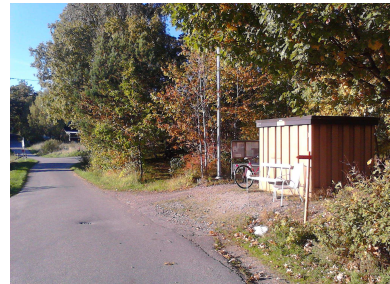
Transformatorstationen inom planområdet.
